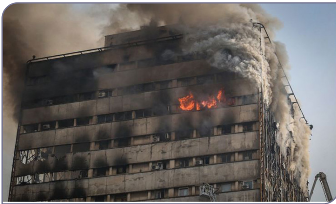
شکل ۴-۱. حادثه آتش‌سوزی پلاسکو
