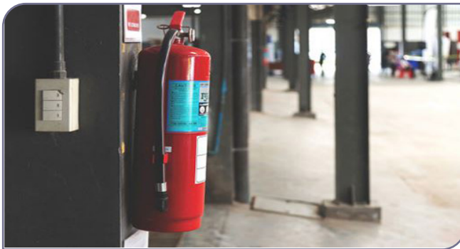
شکل ۹-۳. نصب خاموش‌کننده در انبار
