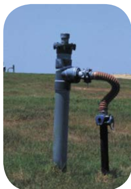
شکل (۲۷) تصویری از چاه واقعی استحصال گاز لندفیل
